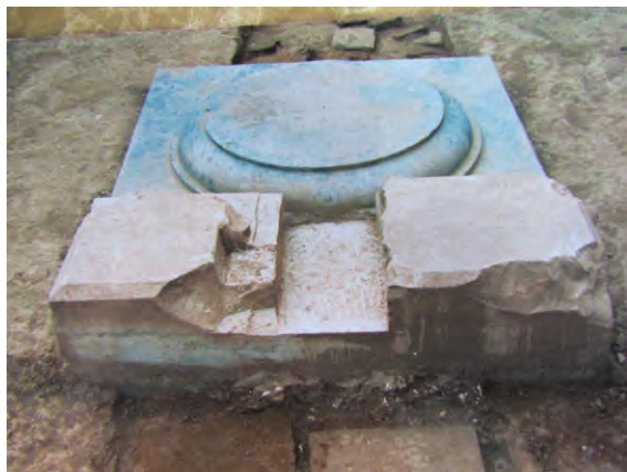
图一〇 内殿的门砧石和柱础
