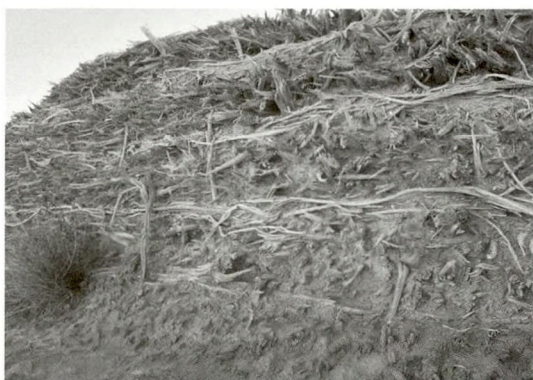
图八 LE 古城柴棍拌泥分层混筑墙体细部
