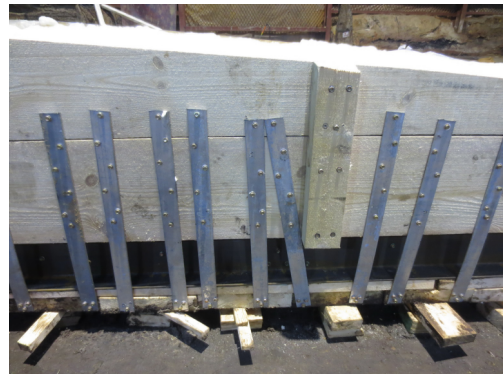
图五 底板与侧板连接
