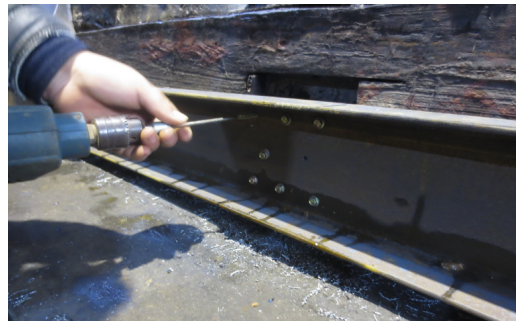
图三 侧面框架连接
