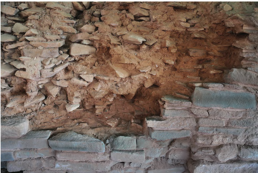
图一〇 皇城台南护墙建筑墙芯
