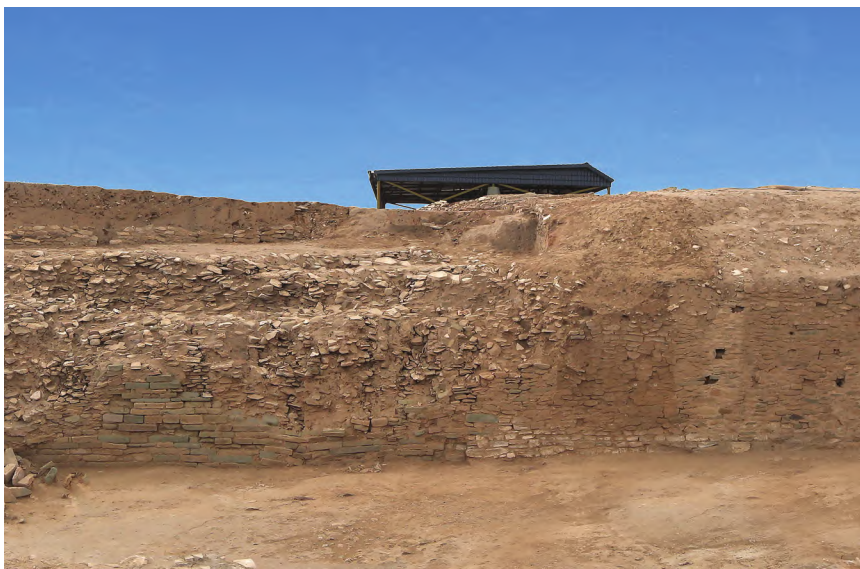
图九 皇城台南护墙建筑外立面
