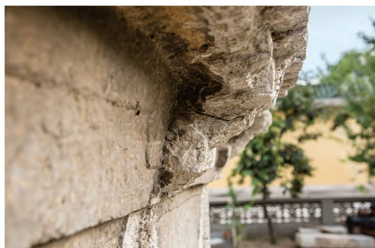
图一五 西檐柱头铺作北侧视
