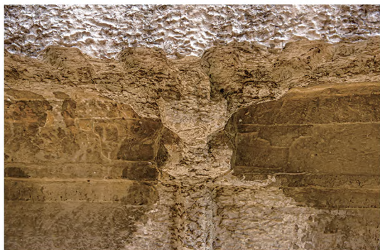
图一二 后檐西柱头铺作正视
