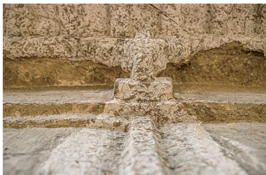
图一六 前檐西柱头铺作仰视
