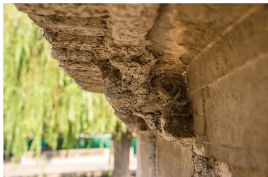
图一三 后檐西柱头铺作西侧视
