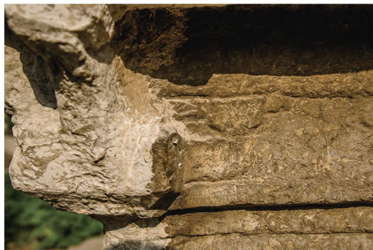
图二一 西北转角南侧泥道拱
