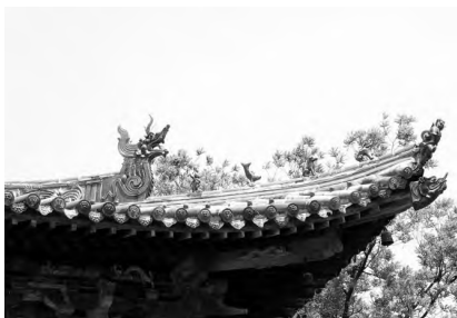
图 31 山西永乐宫元代建筑三清殿翼角
